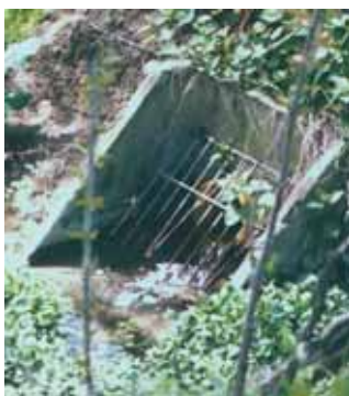
Les risques de transferts sont plus faibles dans les groies moyennes que dans les parcelles drainées de l'Ouest.
