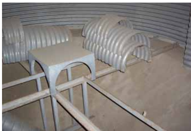
▲ Il faut attacher une très grande attention au nettoyage des parties internes des cellules, ce qui évitera par la suite de les traiter avec un insecticide.
