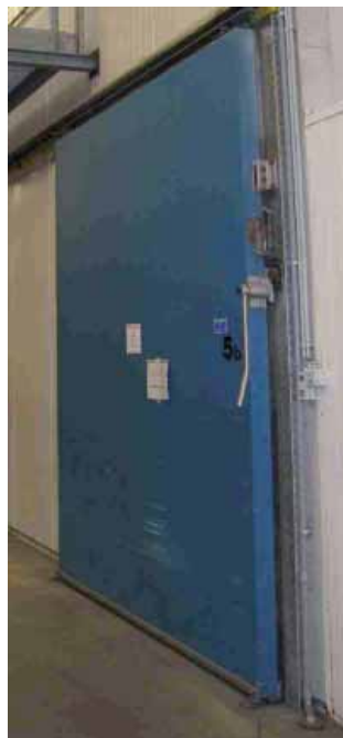
En pratique, la bonne étanchéité de la chambre froide est cruciale pour préserver l'ambiance du stockage au niveau choisi en O 2 et CO 2 : un soin particulier doit être apporté à l'étanchéité des panneaux isolants et de la porte.
