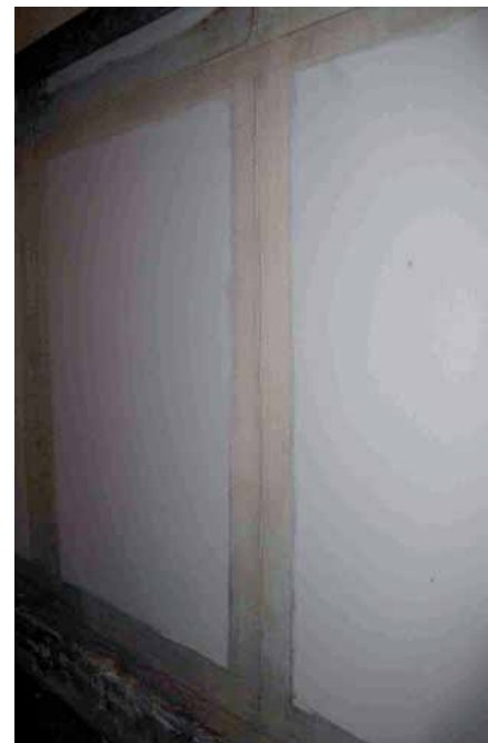
En pratique, la bonne étanchéité de la chambre froide est cruciale pour préserver l'ambiance du stockage au niveau choisi en O 2 et CO 2 : un soin particulier doit être apporté à l'étanchéité des panneaux isolants et de la porte.
