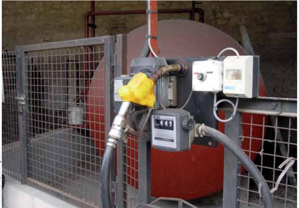
Pour un stockage sous bâti ayant une capacité supérieure à 2 500 l, le local utilisé doit être construit avec des matériaux résistants au feu et exclusivement réservé au stockage du fuel.
