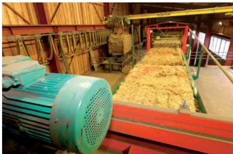
La chaudière brûle 1,5 tonne de paille décompactée à l'heure. Un stockage intermédiaire permet une autonomie de 4 jours, soit 240 bottes.
