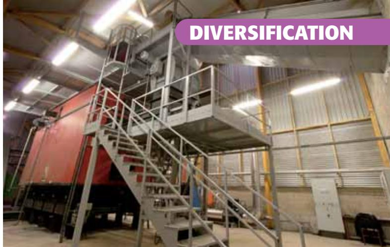
D'une puissance de 5 MW, la chaudière est équipée d'un système de recyclage des fumées, coûteux, mais qui limite fortement les émissions de monoxyde d'azote.
