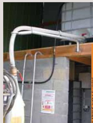
Une réserve d'eau intermédiaire avec potence offre une rupture entre le réseau d'eau et la cuve du pulvérisateur.
