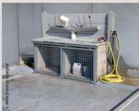
La paillasse de préparation peut être équipée d'un 2<sup>e</sup> point d'eau et d'un égouttoir à bidons.
