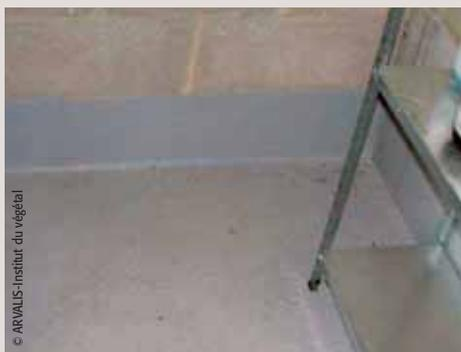
Pour retenir d'éventuelles fuites, le sol doit être étanche et muni d'une rétention (bas de mur enduit).
